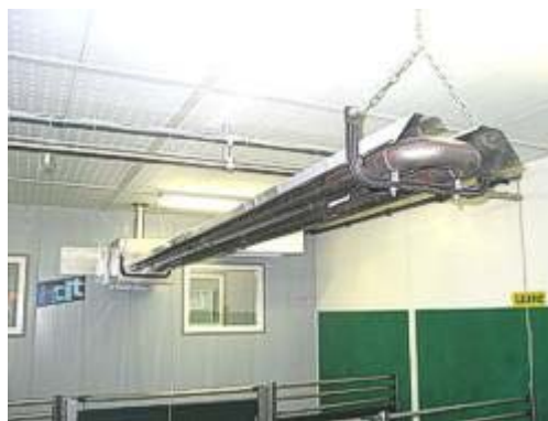
Bild 6: Dunkelstrahler
