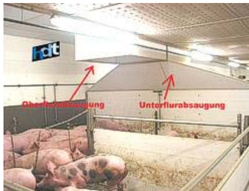
Bild 4: Unterflurabluft
