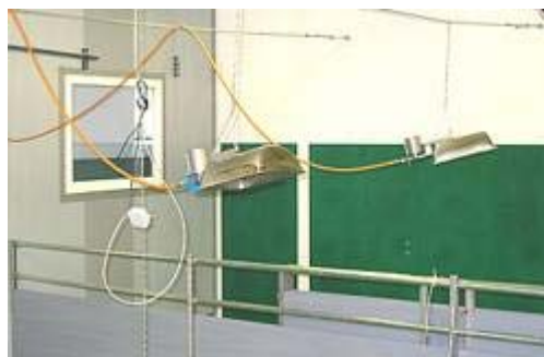
Bild 7: Edelstahlgasstrahler
