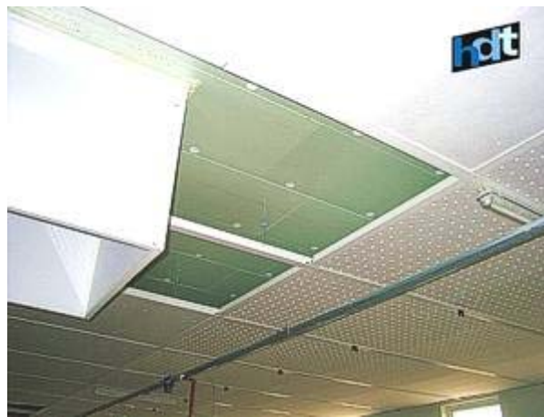
Bild 3: Zwischendecke bei der Montage
